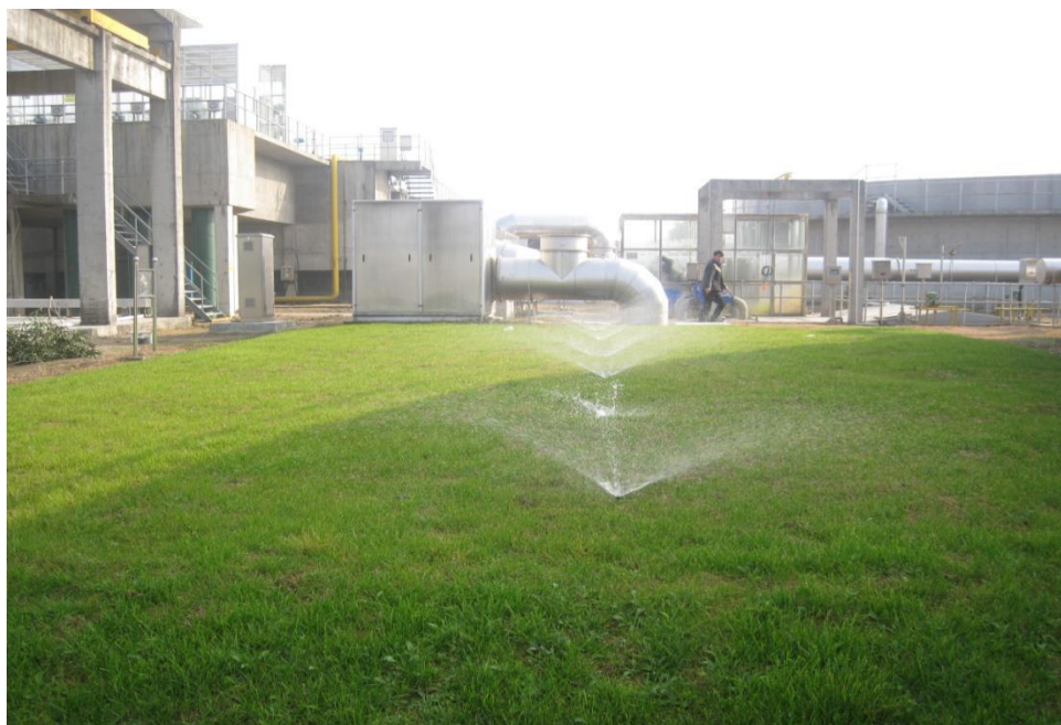
图 4-5 生物土壤滤池除臭系统安装图片
